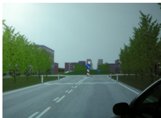
Figur 2. Rundkørsel med acceptable oversigtsforhold. Her er plantet træer i tilfarten med en indbyrdes afstand på 6 m. Højde på midterø er 1,90 m inkl. beplantning.
