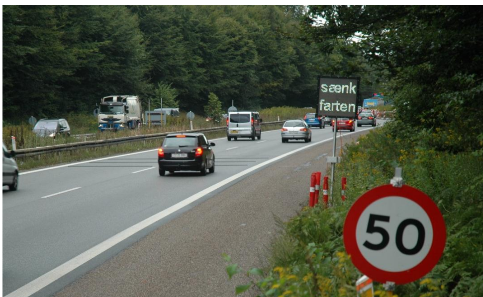
Foto 3.15: Den elektroniske tavle med budskabet SÆNK FARTEN er her placeret FØR rumlestriberne på strækning med skiltet 50 km/t.
