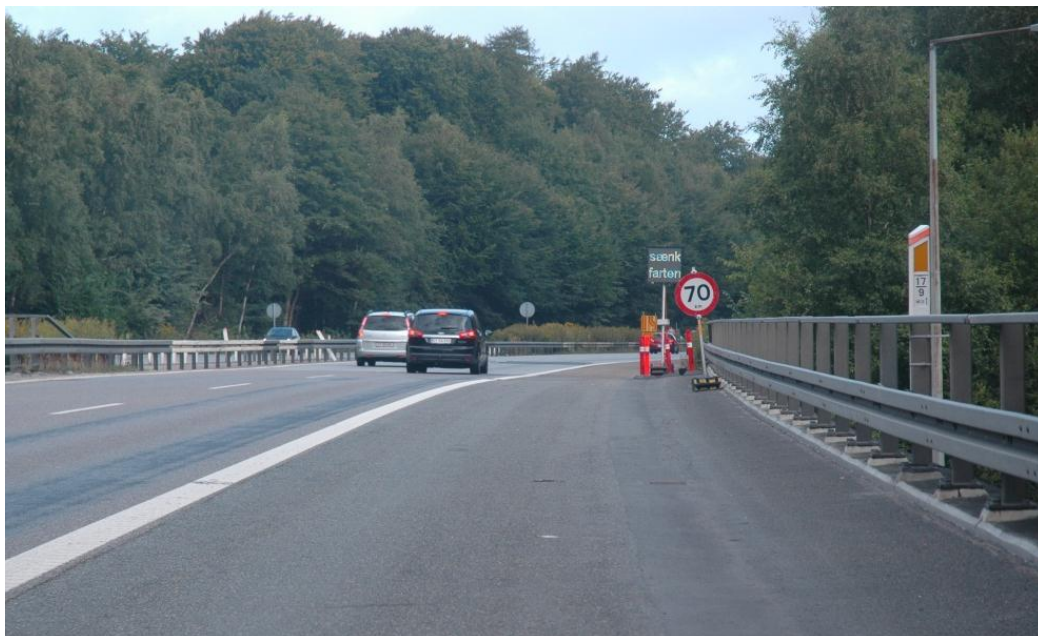
Foto 3.12: Den elektroniske tavle med budskabet SÆNK FARTEN er her placeret FØR rumlestriberne på strækning med skiltet 70 km/t.
