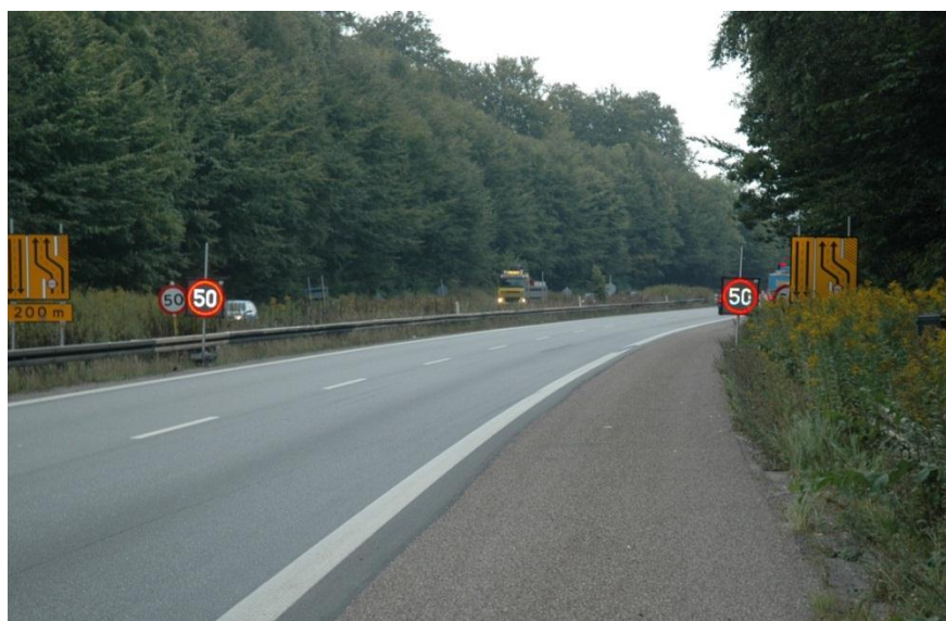
Foto 3.20: Den faste C55 tavle med 50 km/t er suppleret med en VMS tavle
